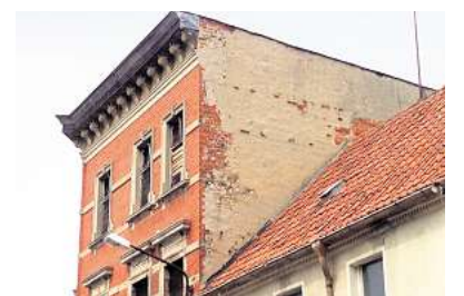
Das Haus bekommt eine Noteindeckung aus Profilblech. FOTO: M. ANKE
